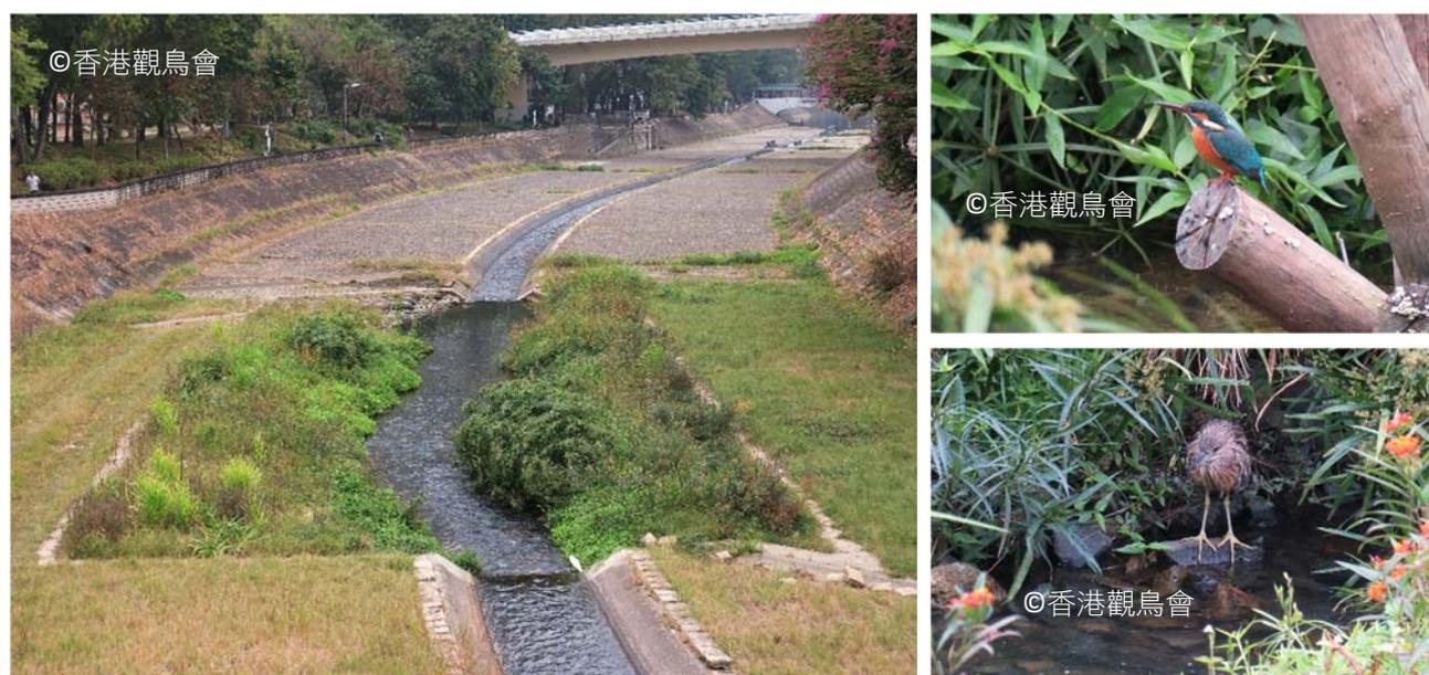
圖十二 渠務署在「綠化河道的生態水力學研究」中改善了一段已渠道化的下林村河。利用天然物料鋪設河床並在河道種植，豐富了河道的生境，吸引了不少水鳥及依賴濕地的雀鳥物種。
